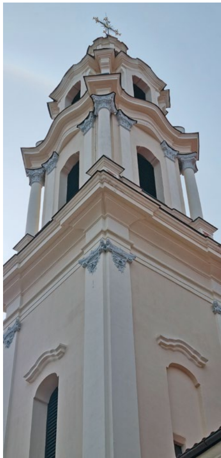
11. Vilniaus Šv. Rapolo bažnyčios bokštas, Aukšės Kaladžinskaitės nuotrauka, 2022
